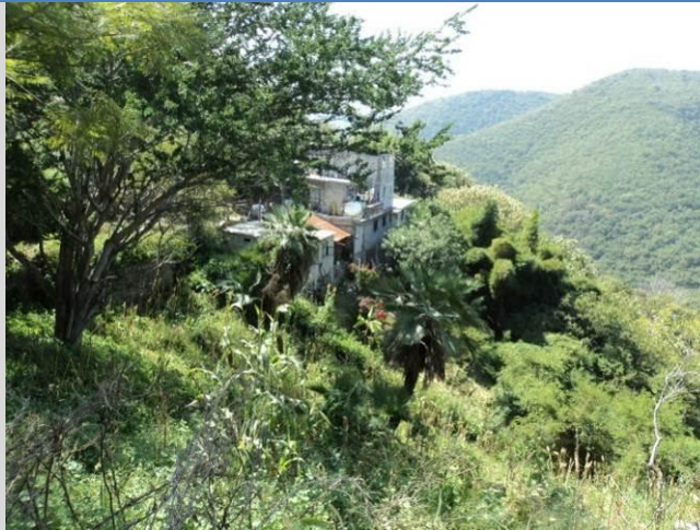
LOCALIDAD LA JOYA Vivienda en terreno con pendiente.
