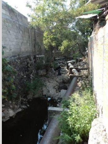
LOCALIDAD LOS ARCOS Tubería sobre el cauce del río.
