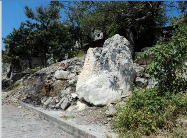
LOCALIDAD LA JOYA Caída de material.
