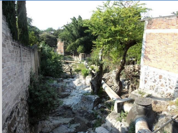
LOCALIDAD LOS ARCOS Cauce del río.
