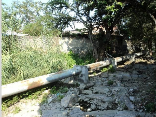
LOCALIDAD LOS ARCOS Cauce del río.
