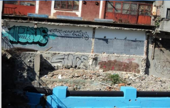
Imagen 34. Obras efectuadas en las márgenes del Río Yautepec
