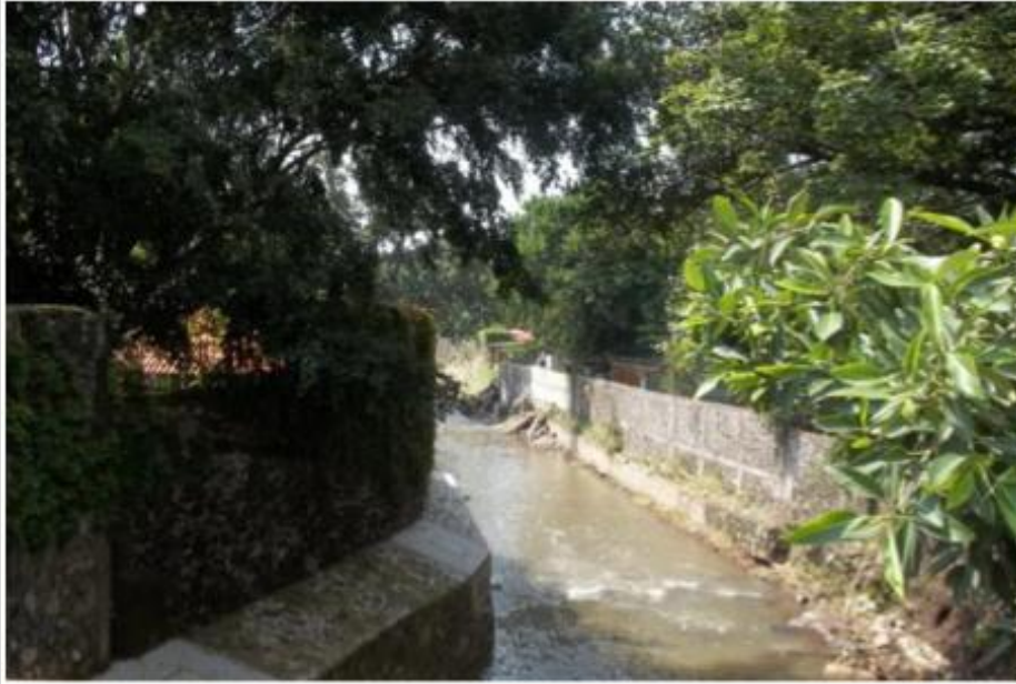
Imagen 20. Vista de los colectores actualmente
