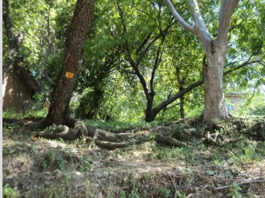
LOCALIDAD LA JOYA La raíz de los árboles ya están casi en la superficie.
