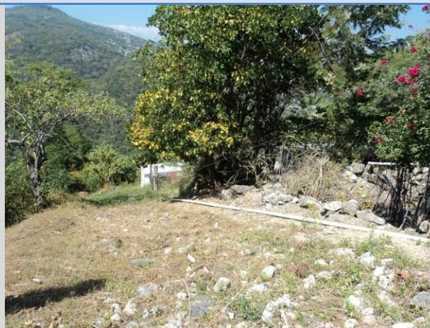
LOCALIDAD LA JOYA Viviendas construidas sobre terrenos con pendiente.
