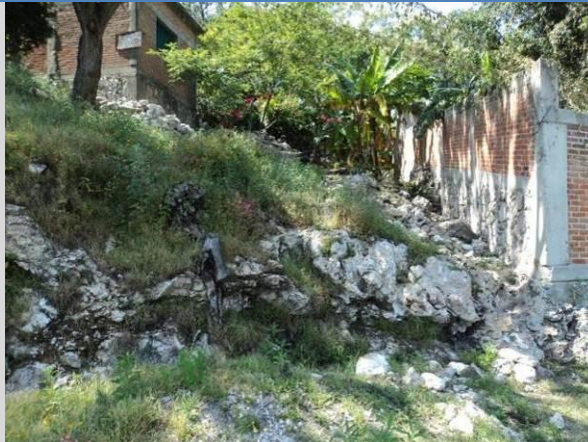
LOCALIDAD LA JOYA Presencia de material calcario.
