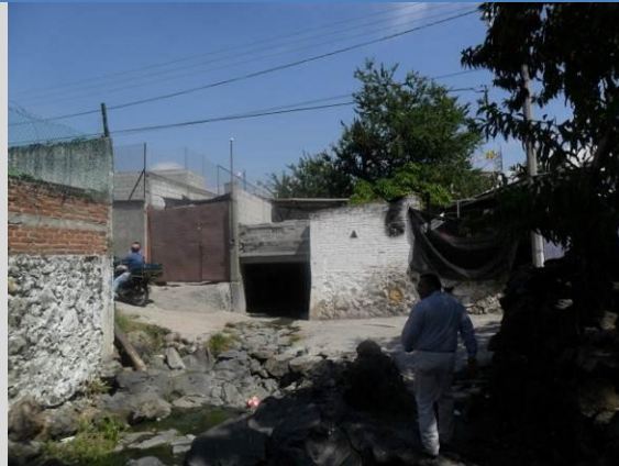
LOCALIDAD OAXTEPEC Construcción de dique.
