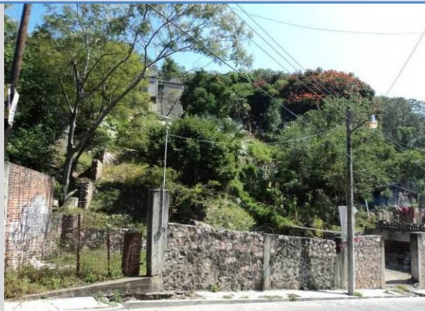
LOCALIDAD LA JOYA Viviendas en La Joya.
