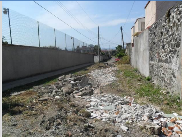
LOCALIDAD OAXTEPEC Los habitantes han rellenado con cascajo la calle.
