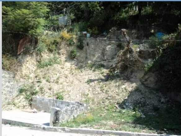
LOCALIDAD LA JOYA La población ha sacado material para construir quedando a la orilla de la calle.
