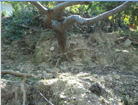
LOCALIDAD LA JOYA La raíz de los arboles al descubierto, proceso de reptación.
