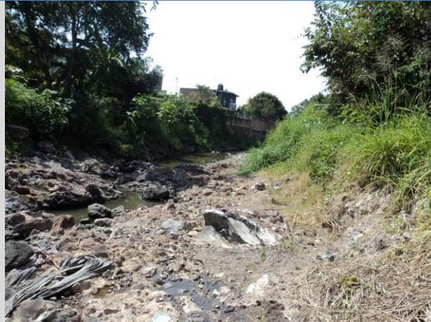
LOCALIDAD OACALCO Cauce del río cerca del puente principal.
