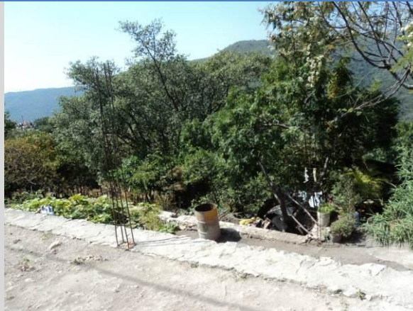
LOCALIDAD LA JOYA Construcción sobre terrenos con pendiente.
